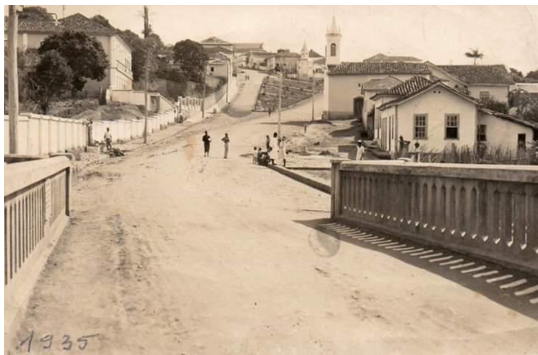
Figura 15: Entrada da cidade, ponte sobre Córrego Maracanã – sem data – Oliveira-MG
